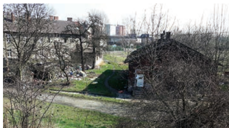
Pohled z mostu na Rudné ulici před demolicí.
