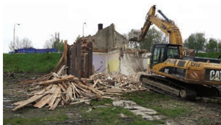
Budovy, které zde dožívaly obklopeny odpadky, byly zbourány.
